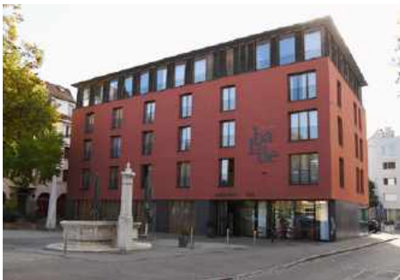
1973 brannte die mittelalterliche Klingental- oder Drachmühle ab. Im ursprünglichen Kubus der Mühle entstand ein Neubau (Silo). Dieser wich 2001 dem Hotel Balade.
