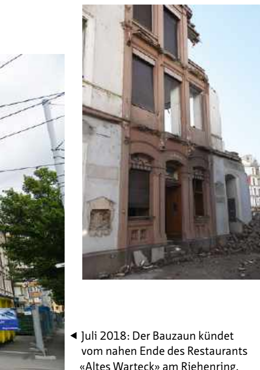
◀ Oktober 2019: Die Ruinen einer 160-jährigen Kleinbasler Tradition. Hier entsteht derzeit der Claraturm.
