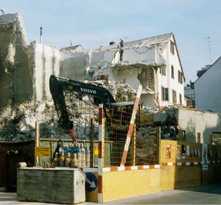
Abbruch der Klingentalmühle im Jahr 2000.
