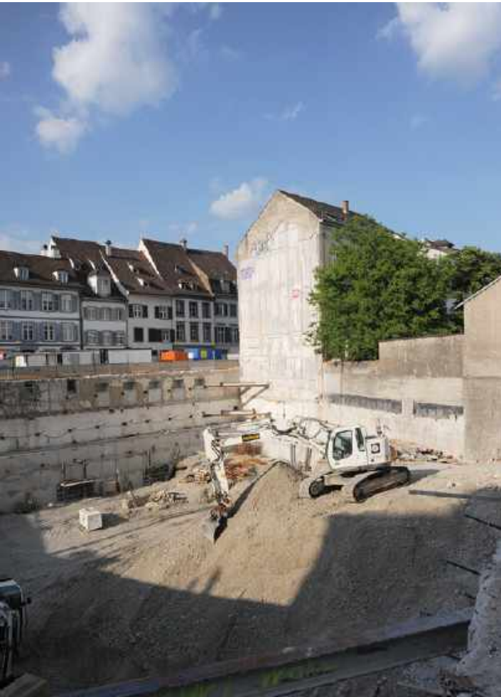
Juni 2013: Blick in die Baugrube.
